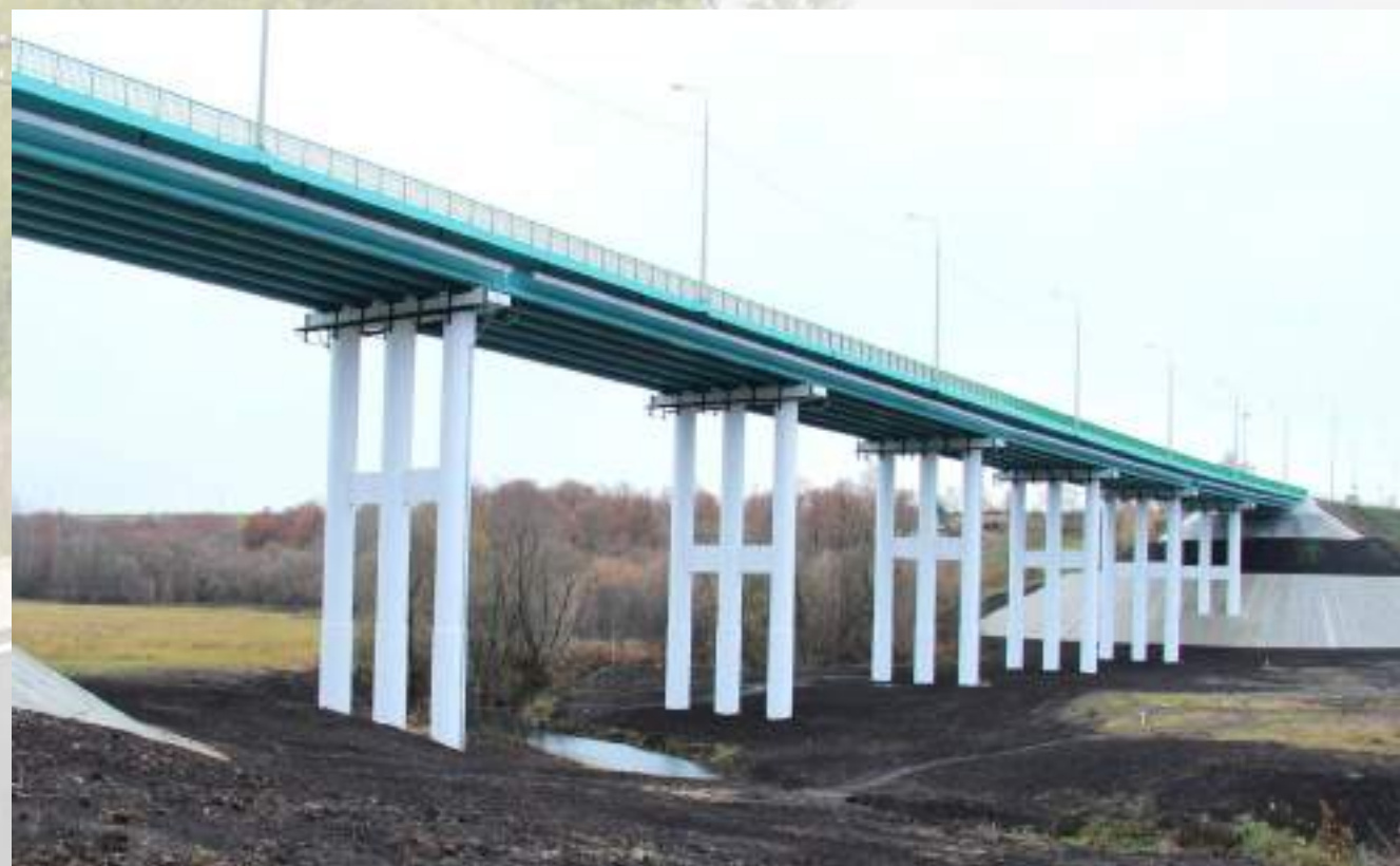
Отремонтированный мост через реку Кунач
