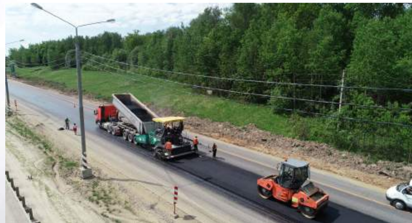
Капитальный ремонт автодороги М-2 «Крым» км 131(А-5)
