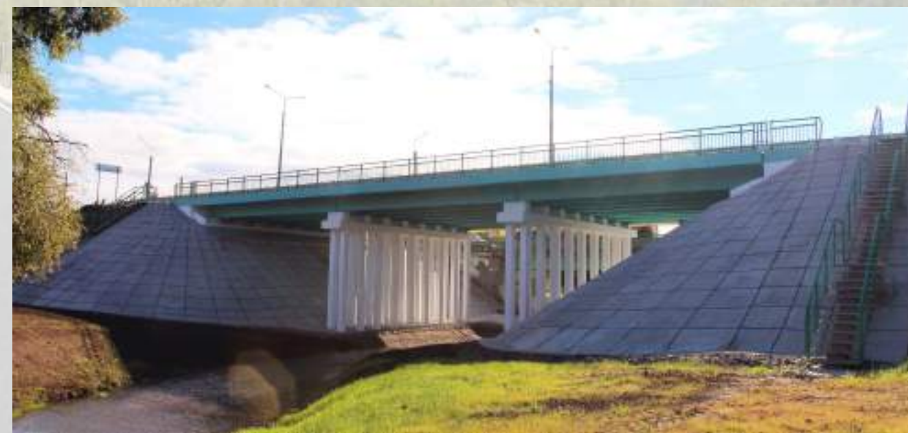
Мост через реку Нюховка
