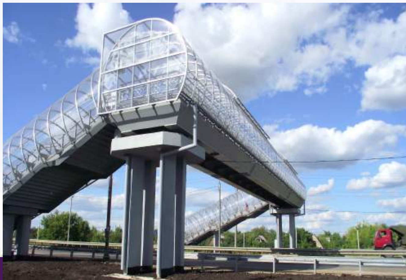
Построенный надземный пешеходный переход, км 301 автодороги Р-119 Орёл–Тамбов
