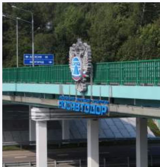
Герб Федерального дорожного агентства на пролётном строении путепровода, расположенного на 134-м километре автомагистрали М-2 «Крым»
